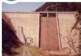
1979-1983 (昭和54年～昭和58年) 山の口ダム建設工事
