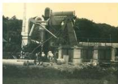
1964 (昭和39年) アスファルトプラント
