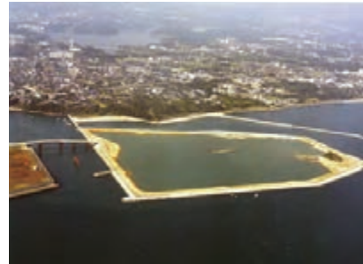
1988-2001 (昭和63年～平成13年) 山口宇部空港滑走路延長 (2500m) 工事
