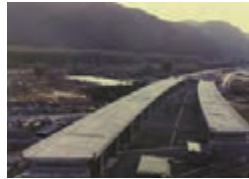
1984-1986 (昭和59年～昭和61年) 山陽自動車道 藤河高架橋工事
