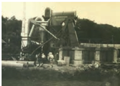
1964 (昭和39年) アスファルトプラント
