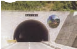
1996-1997 (平成8年～平成9年) 県道柳井周東線道路 (大江トンネル)改良工事
