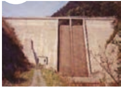
1979-1983 (昭和54年～昭和58年) 山の口ダム建設工事
