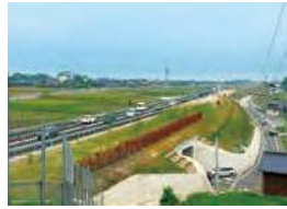
2015-2016 (平成27年～平成28年) 東九州自動車道 椎田南豊前舗装工事
