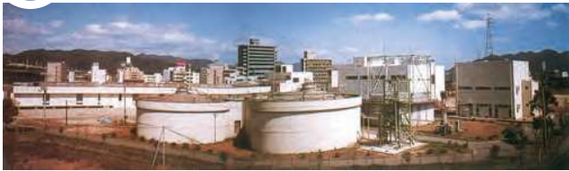
1982-1992 (昭和57年～平成4年) 小郡長谷終末処理場工事
