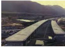
1984-1986 (昭和59年～昭和61年) 山陽自動車道 藤河高架橋工事
