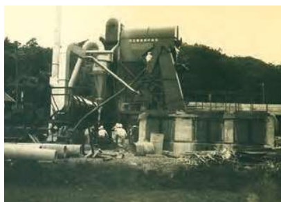
1964 (昭和39年) アスファルトプラント
