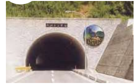
1996-1997 (平成8年～平成9年) 県道柳井周東線道路 (大江トンネル)改良工事
