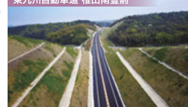
バックドレーン工事
