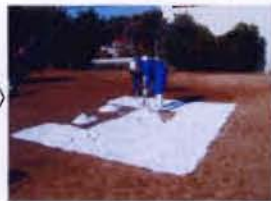
② 敷き均し
