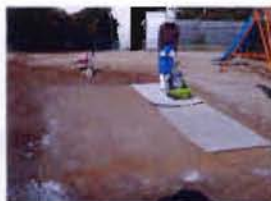
⑤ 転 圧・散 水
