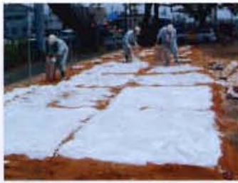
②【敷き均し】
